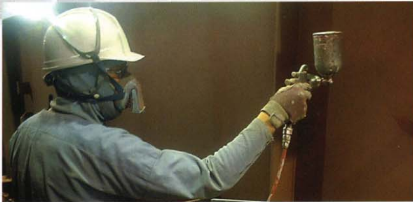
ハイボン導電プライマーの塗装↑
