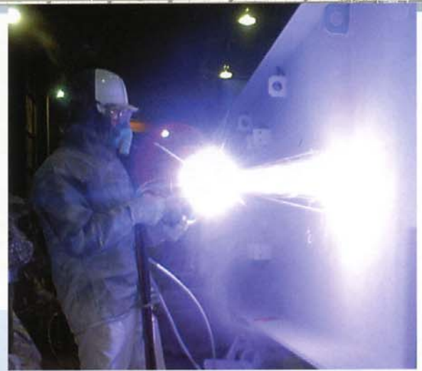
溶射の施工↑
