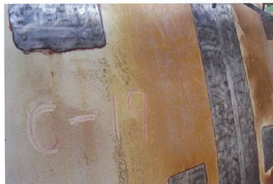
3 電動工具にて表面仕上げをしました。
