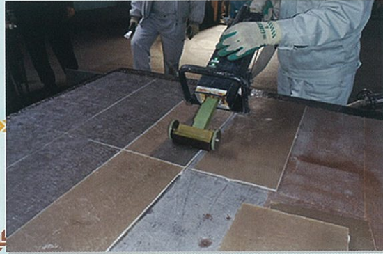
2 剥離対象箇所以外は影響を受けていないのが分かります。
