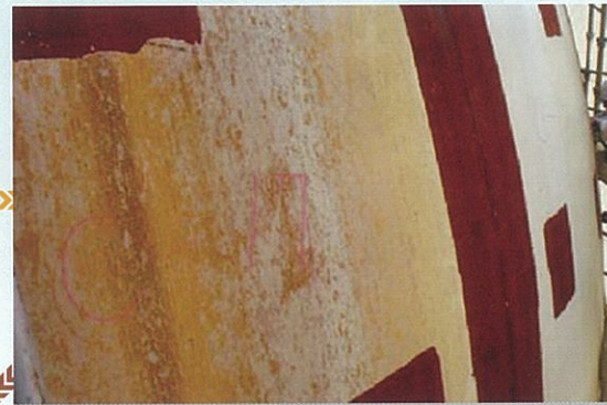
2 表面塗膜を除去し、最下層の鉛丹塗膜が薄く残った状態。残存膜厚10~30μm。
