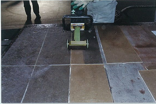
1 剥離したい箇所のFRP上を誘導ヘッドを通します。
