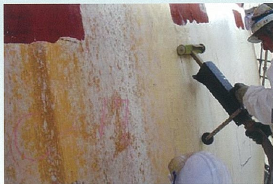
1 剥離したい箇所の被膜上を誘導ヘッドを通します。
