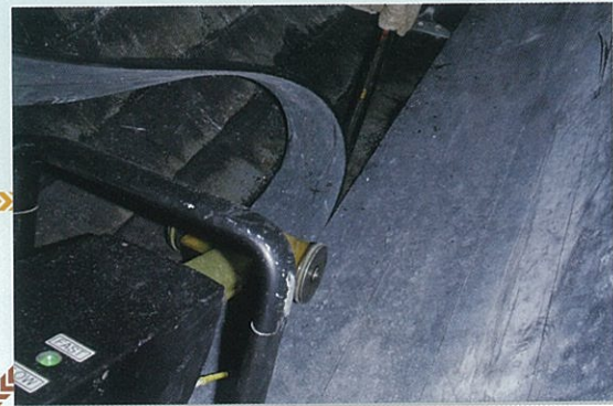
2 軟質ゴムをスクレーパー等を使い剥離させます。
