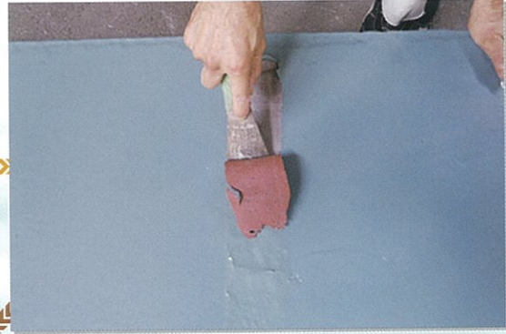
2 被膜が、浮き上がるのでスクレーパー等で軽くケレンを行います。
