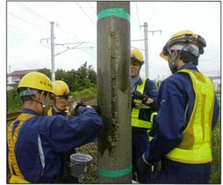
プライマー塗布
