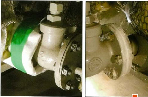
補修前 (養生撤去前)・(養生撤去後)
