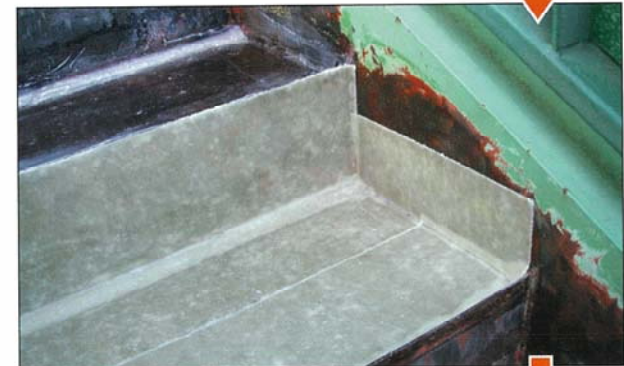
ウルトラパッチ貼付 (ササラ部)
