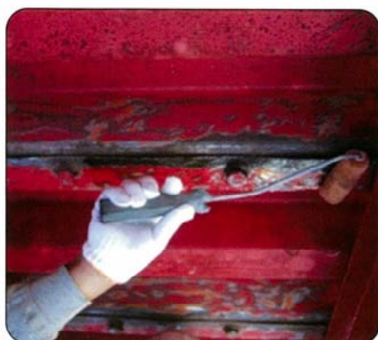
プライマー塗布
