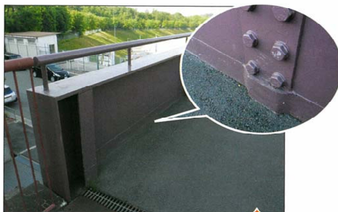
塗装後、補修完了
