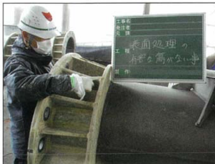
灯具継部 (施工後)
