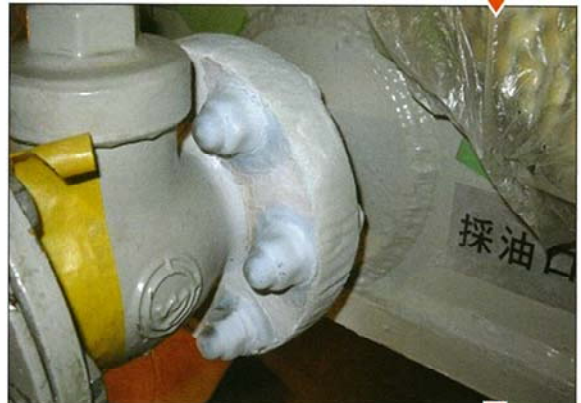
リークチェック (漏油の有無確認 / 漏油無し)
