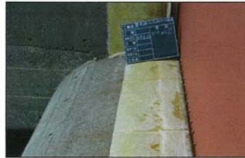
補修後（7年経過）
