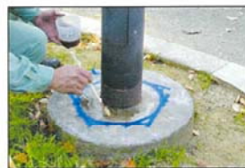
プライマー塗布
