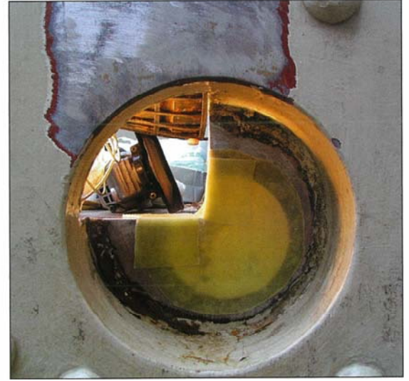
ウルトラパッチ硬化後
