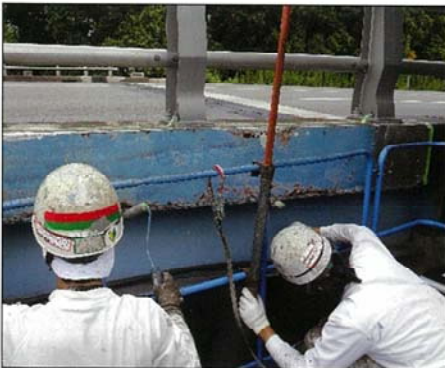
プライマー塗布
