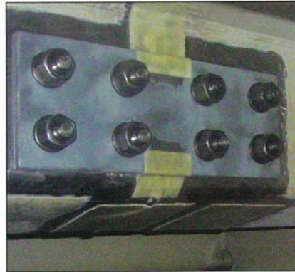
ウルトラパッチ硬化後
