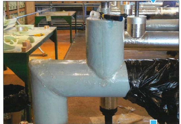
ウルトラパッチ貼付完了
