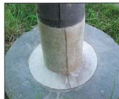
施工後(平成19年4月)
