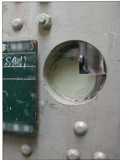
ウルトラパッチ貼付後
