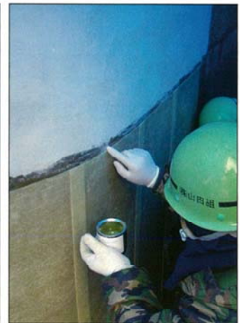
ウルトラパッチペーストにて端部処理
