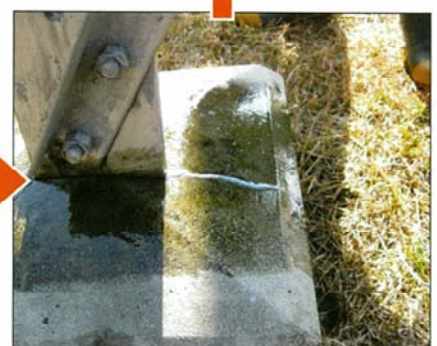
仕上げにウルトラシール塗布
