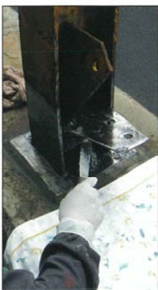
プライマー処理/不陸調整
