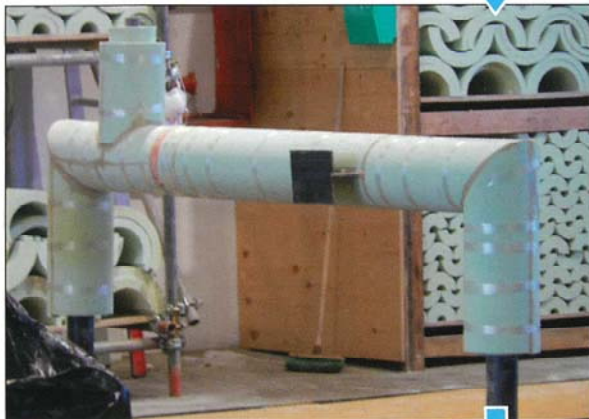
保温材巻き付け完了
