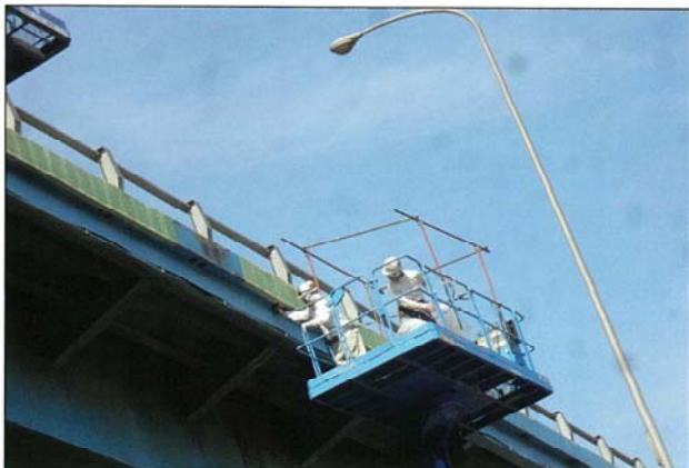
ウルトラパッチ貼付状況
