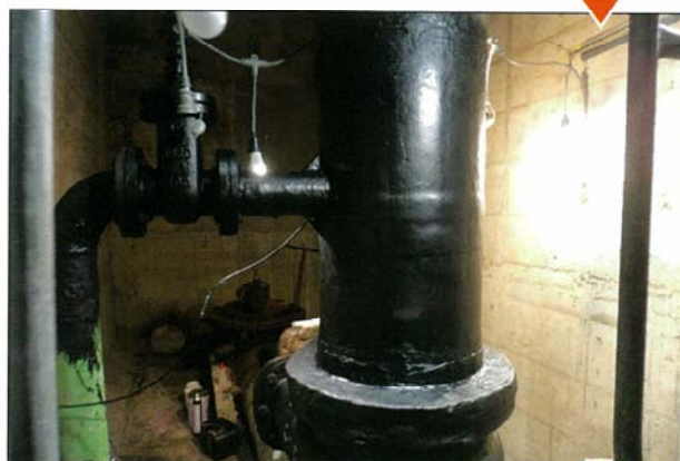
補修・塗装完了
