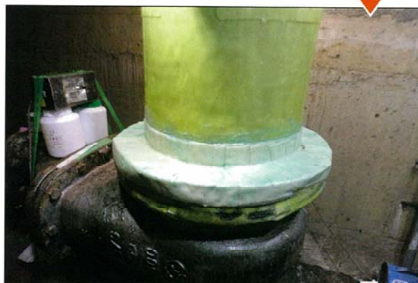
ウルトラパッチ貼付け完了
