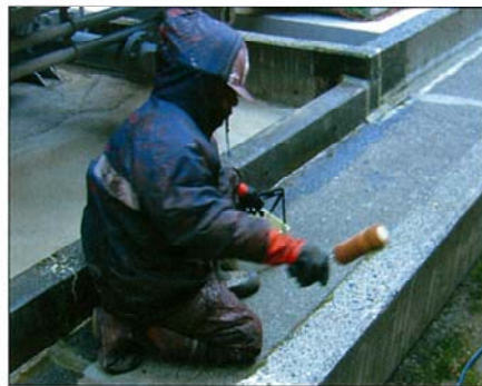
プライマー塗布
