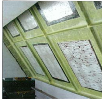
ウルトラパッチ貼付 (1層目)
