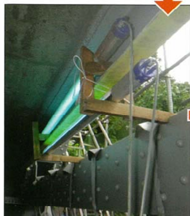
ウルトラパッチ貼付後、紫外線照射
