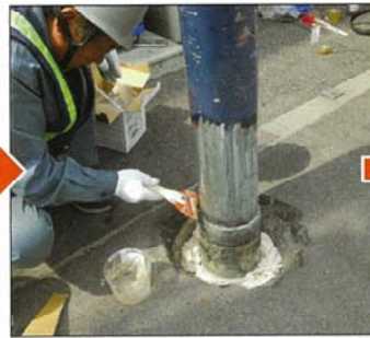
プライマー塗布・MGパテで不陸調整
