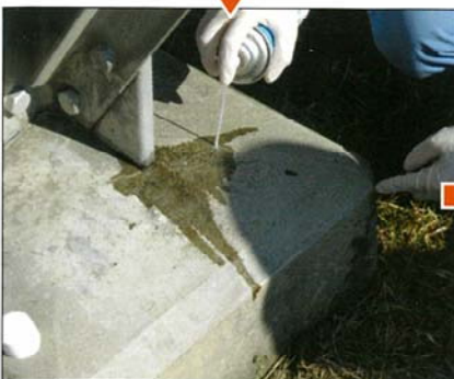
補修部分を洗浄
