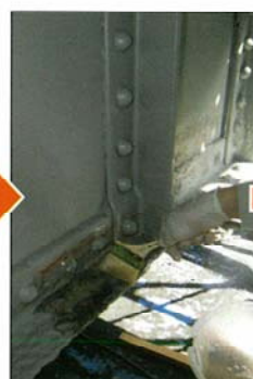
プライマー塗布
