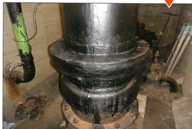
補修・塗装完了 (フランジ部)
