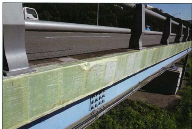
ウルトラパッチ硬化後
