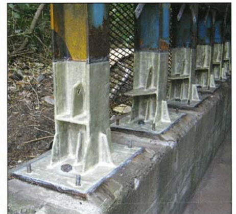
ウルトラパツチ硬化完了
