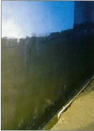
プライマー塗布
