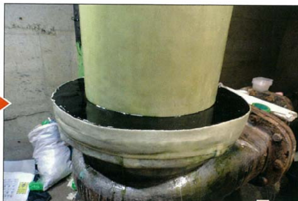
ウルトラコート充填完了
