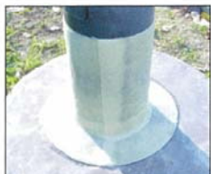
施工直後(平成12年4月)
