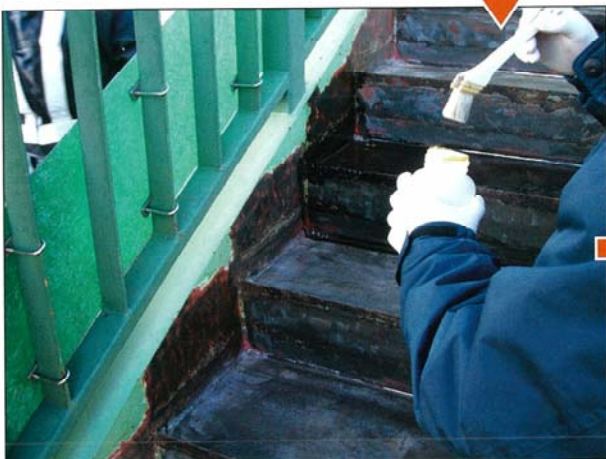
プライマー塗布
