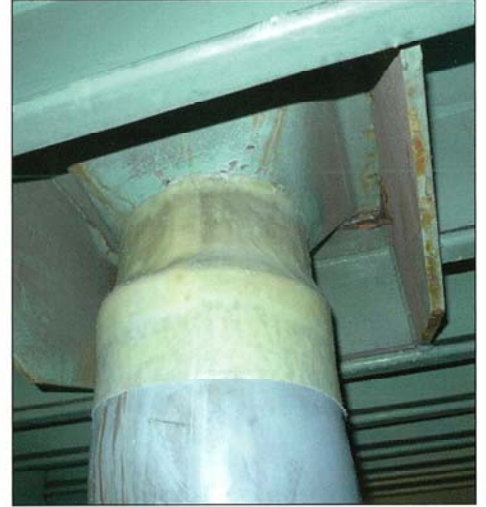
ウルトラパッチ貼付後
