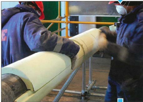
保温材巻き付け
