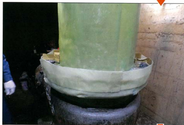
フランジ部にウルトラコートを流し込む為に ウルトラパッチにて型枠作成
