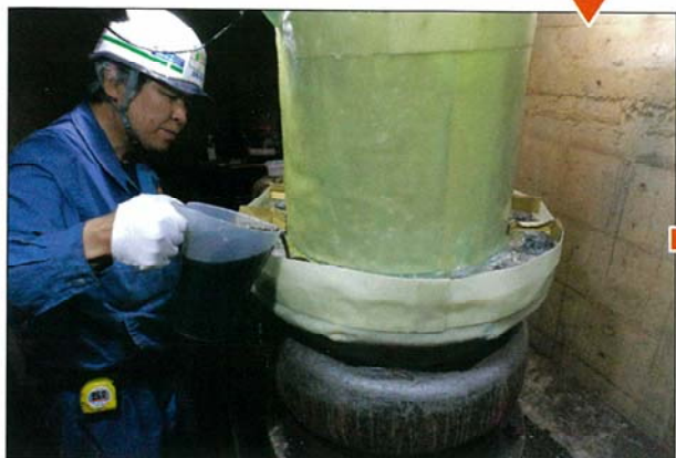
ウルトラコートをフランジ部に充填
