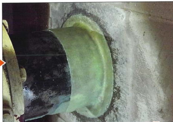
壁面際根巻にウルトラパッチ貼付
