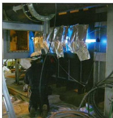
紫外線照射 (アルミシートを使用し反射)
