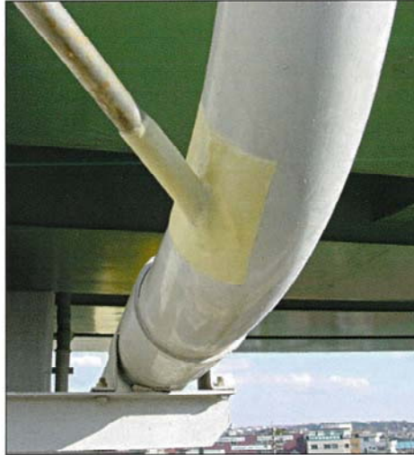
ウルトラパッチ貼付後
