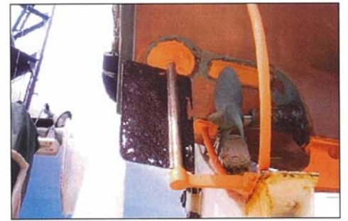
補修前腐食状況
