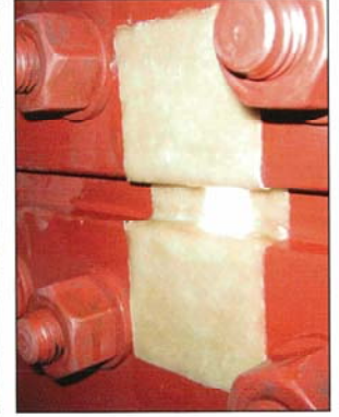
ウルトラパッチ貼付後
