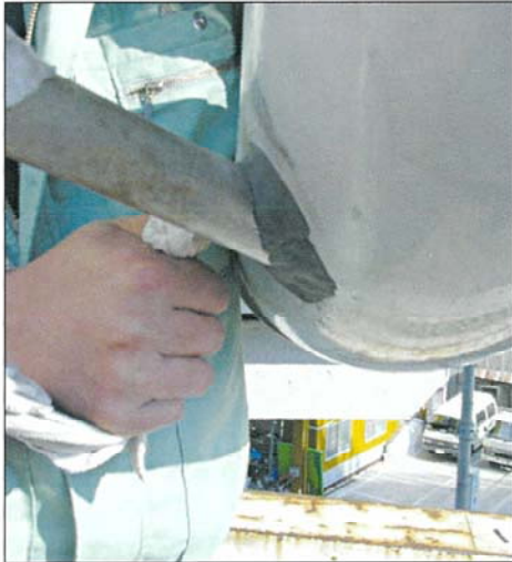
欠損部フィックスオールパテ充填
