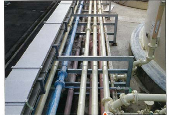
塗装後、補修完了
