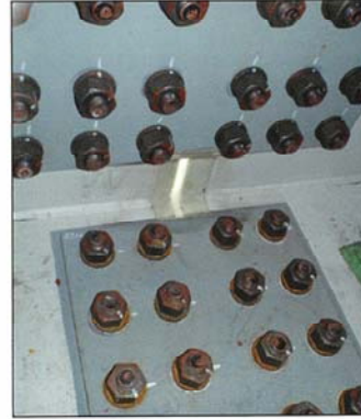
ウルトラパッチ貼付後
