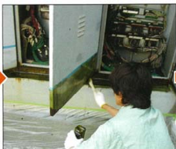
プライマー塗布
