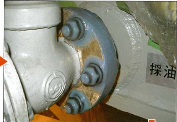
ボルトキャップ取付 & ウルトラシール塗布
