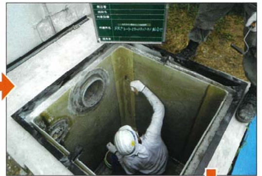
プライマー塗布
