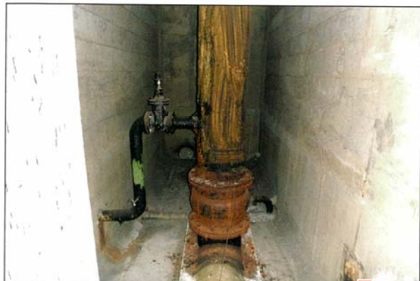
補修前 (立坑全体)
