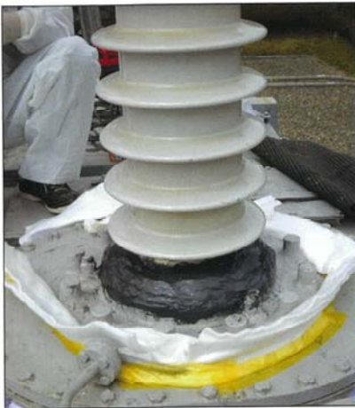
補修前(養生撤去)
