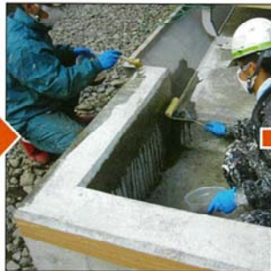
プライマー塗布
