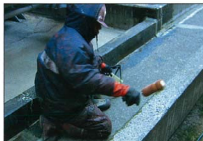
プライマー塗布
